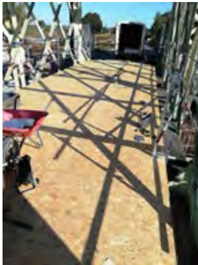
Aménagement du pont SNCF
